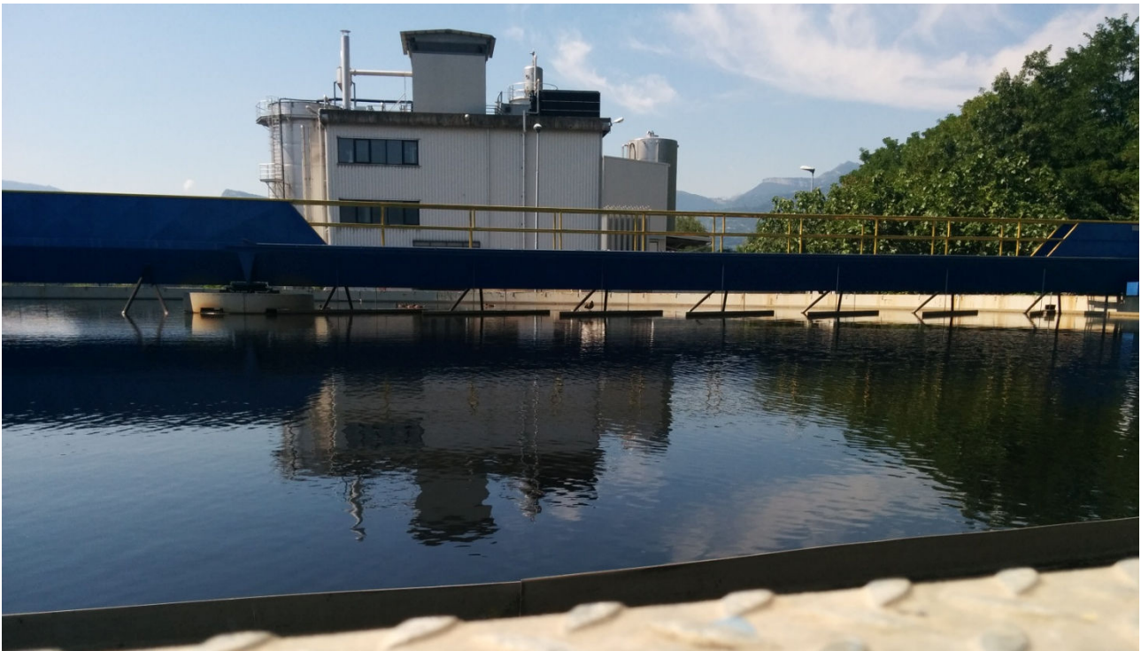
Fig. 2. Fase di misura all'interno degli impianti di depurazione delle acque e Forsu, in Loc. Navicello a Rovereto (TN).
